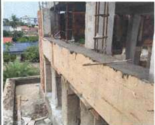
PEKERJAAN STRUKTUR PENGECORAN PAGAR PROFIL
