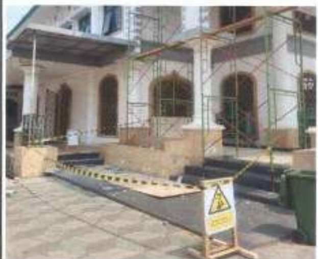
PEKERJAAN PERSIAPAN PEMASANGAN RAMBU DAN SAFETY LINE
