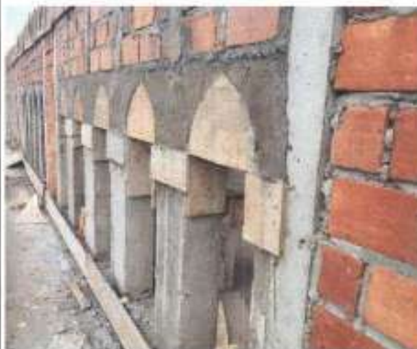
PEKERJAAN STRUKTUR PEMASANGAN BATU BATA PAGAR PROFIL
