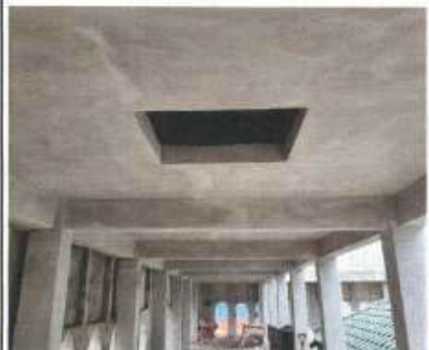
PEKERJAAN STRUKTUR PEMASANGAN STEK REBAR HILTI
