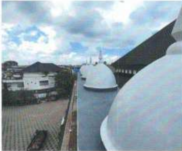
PEKERJAAN PENGECATAN PENGECATAN DINDING GAWANGAN
