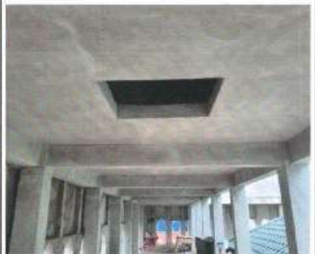
PEKERJAAN ARSITEKTUR PEMBUATAN KACA INLAY
