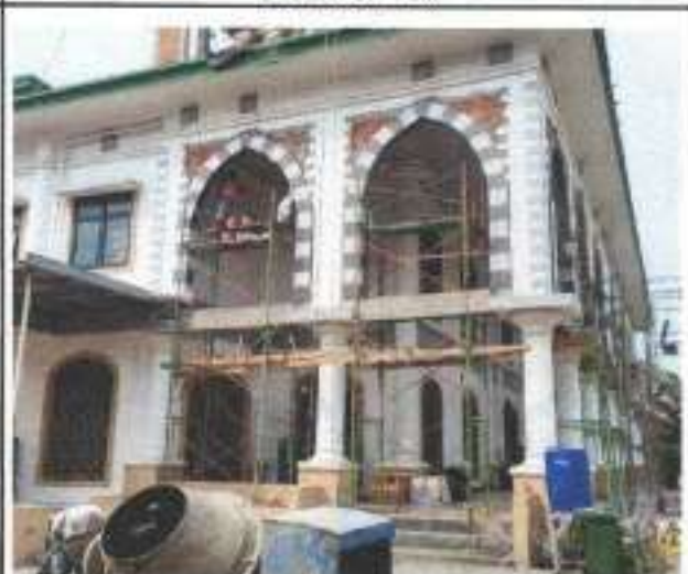
PEKERJAAN ARSITEKTUR PEMANGSANGAN GRANIT TILE GAWNGAN
