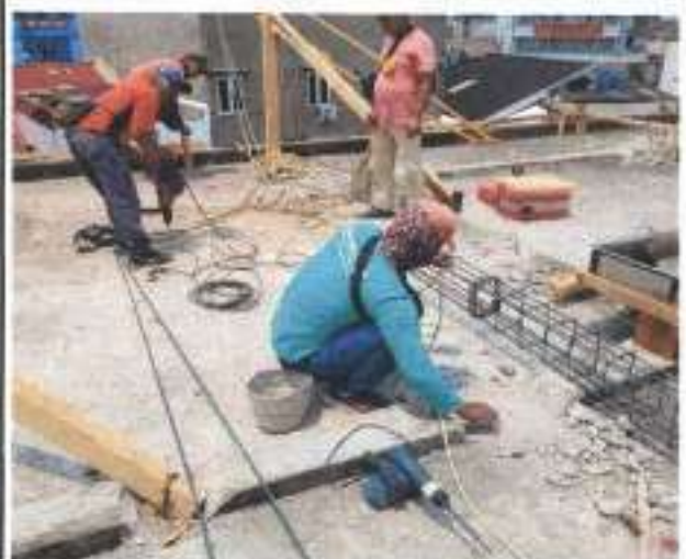
PEKERJAAN STRUKTUR PEMASANGAN STEK REBAR HILT
