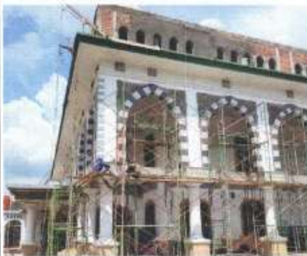
PEKERJAAN ARSITEKTUR PLESTERAN GAWANGAN DAN PAGAR PROFIL
