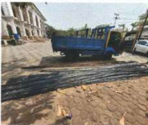
PEKERJAAN PERSIAPAN MOBILISASI MATERIAL DAN PERALATAN
