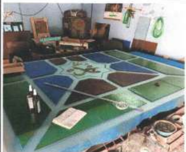
PEKERJAAN ARSITEKTUR PEMBUATAN KACA INLAY
