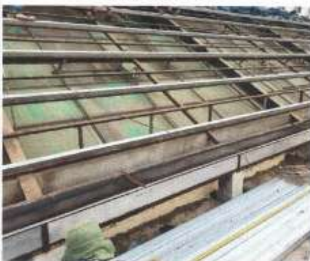
PEKERJAAN STRUKTUR PEMASANGAN RANGKA BAJA RINGAN
