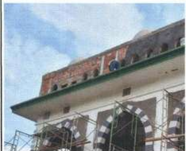
PEKERJAAN STRUKTUR PLESTERAN GAWANGAN DAN PAGAR PROFIL
