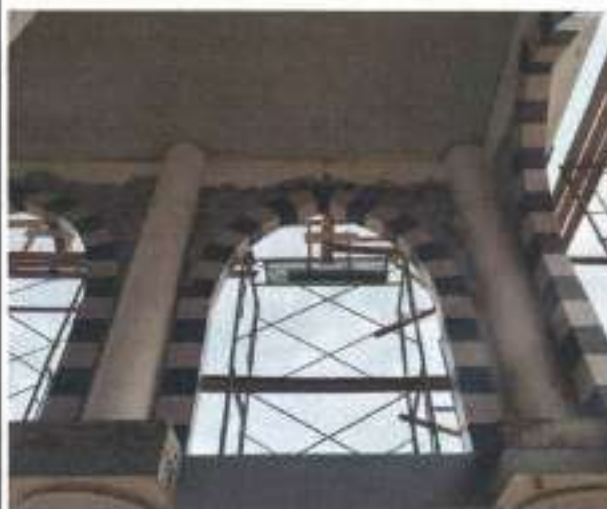
PEKERJAAN ARSITEKTUR PLESTERAN GAWANGAN DAN PAGAR PROFIL
