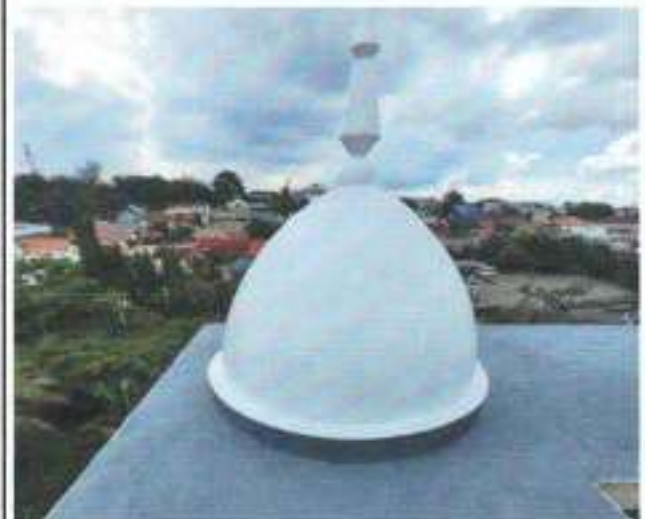
PEKERJAAN ARSITEKTUR PEMBUATAN KACA INLAY
