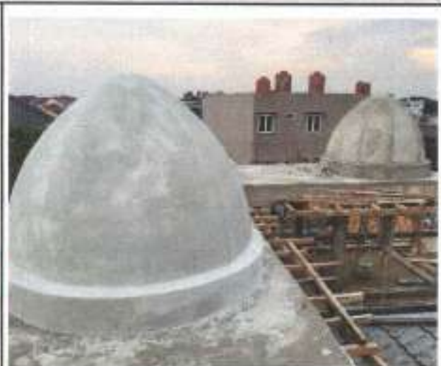
PEKERJAAN ARSITEKTUR ACIAN KUBAH TELOK
