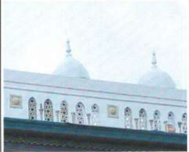
PEKERJAAN PENGECATAN PENGECATAN KUBAH TELOK DAN PAGAR PROFIL
