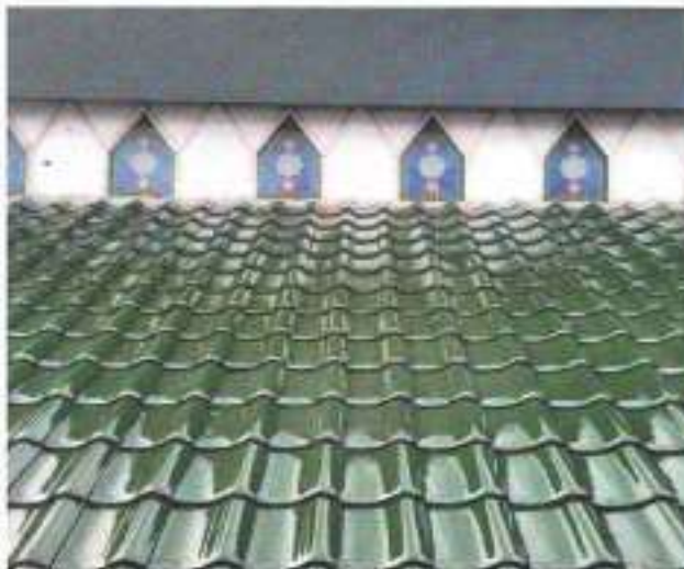
PEKERJAAN ARSITEKTUR PEMBUATAN KACA INLAY
