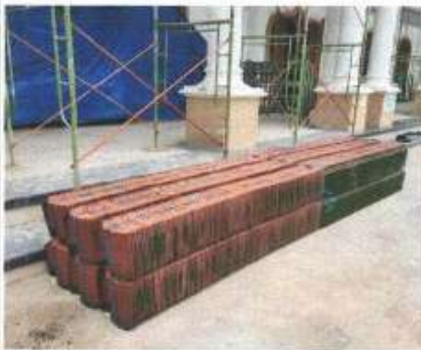
PEKERJAAN STRUKTUR MATERIAL GENTENG M-CLASS
