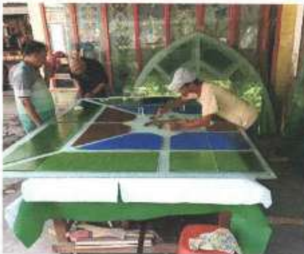
PEKERJAAN ARSITEKTUR PEMBUATAN KACA INLAY
