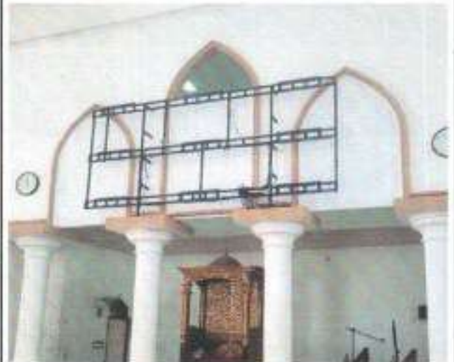
PEKERJAAN PENGECATAN PENGECATAN KUBAH TELOK DAN PAGAR PROFIL
