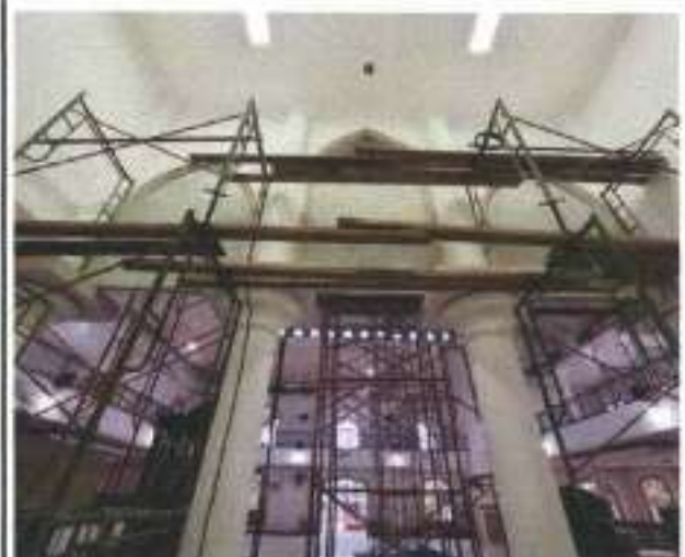
PEKERJAAN ARSITEKTUR ACIAN DAN PENGECATAN DINDING MIHRAB
