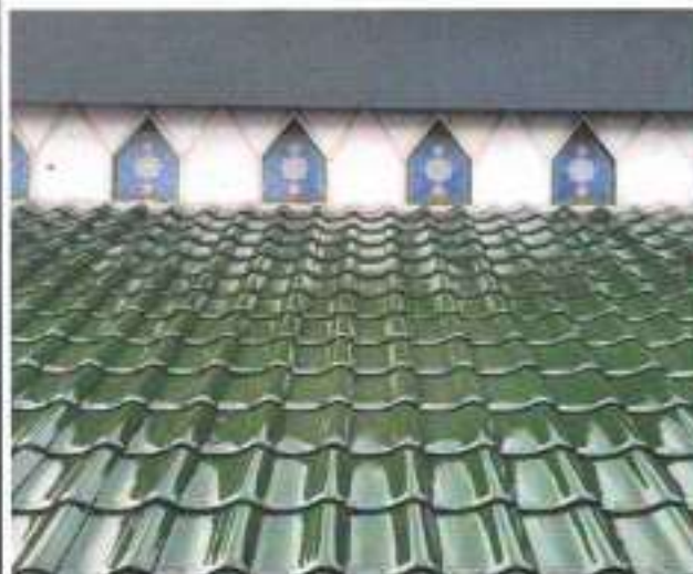
PEKERJAAN ARSITEKTUR PEMBUATAN KACA INLAY
