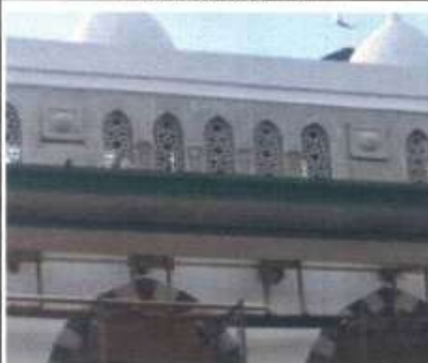
PEKERJAAN ARSITEKTUR PEMASANGAN GRC MOTIF PAGAR PROFIL
