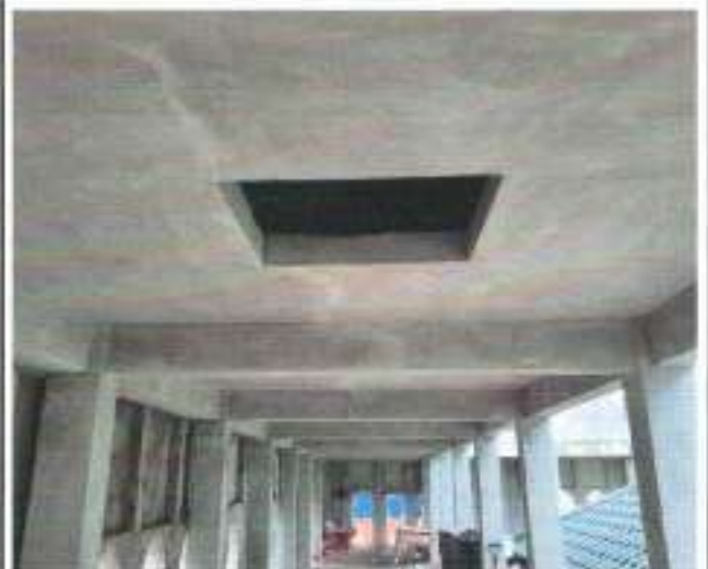
PEKERJAAN ARSITEKTUR PEMBUATAN KACA INLAY
