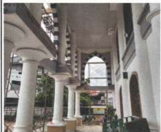
PEKERJAAN ARSITEKTUR PLESTERAN GAWANGAN DAN PAGAR PROFIL
