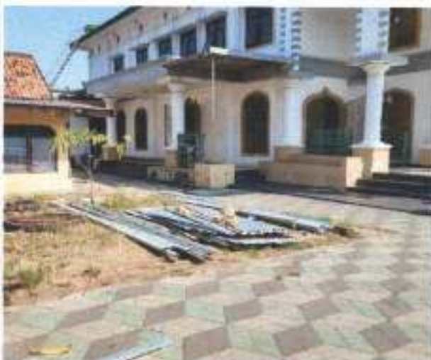
PEKERJAAN PERSIAPAN MOBILISASI MATERIAL DAN PERALATAN
