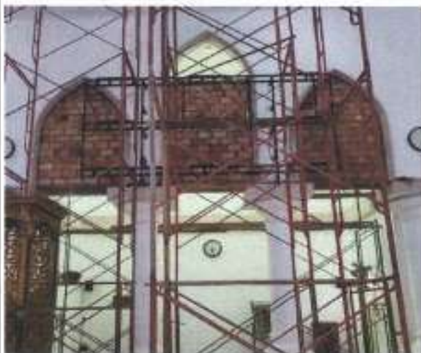
PEKERJAAN ARSITEKTUR PEMASANGAN DINDING MIHRAB
