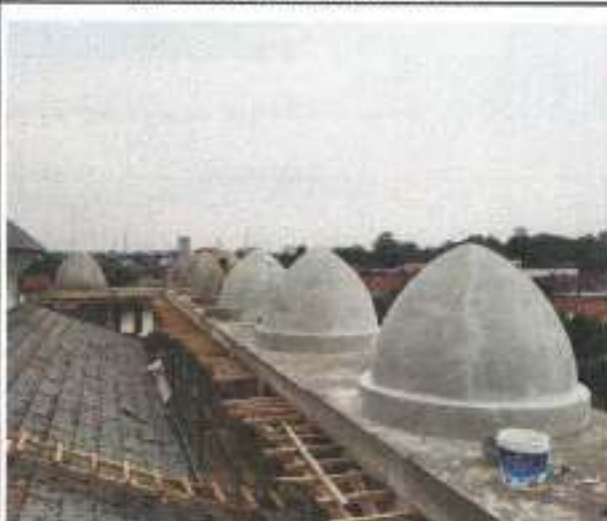
PEKERJAAN ARSITEKTUR ACIAN KUBAH TELOK
