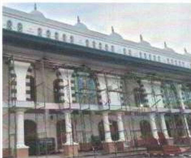
PEKERJAAN PENGECATAN PENGECATAN DINDING GAWANGAN
