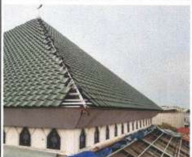
PEKERJAAN STRUKTUR PEMASANGAN GENTENG M-CLASS
