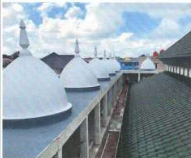
PEKERJAAN ARSITEKTUR PEMBUATAN KACA INLAY
