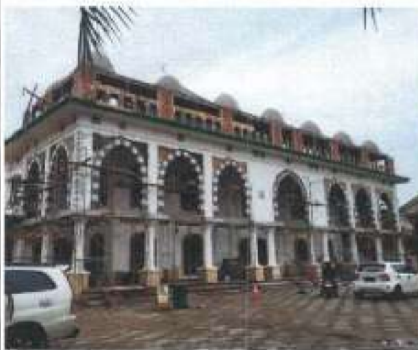
PEKERJAAN STRUKTUR PEKERJAAN PAGAR PROFIL
