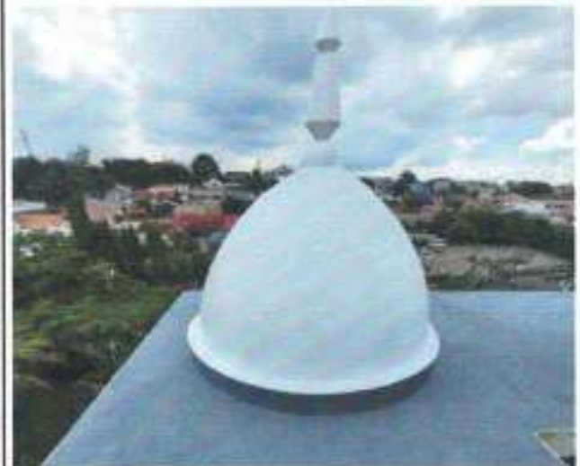
PEKERJAAN ARSITEKTUR PEMBUATAN KACA INLAY
