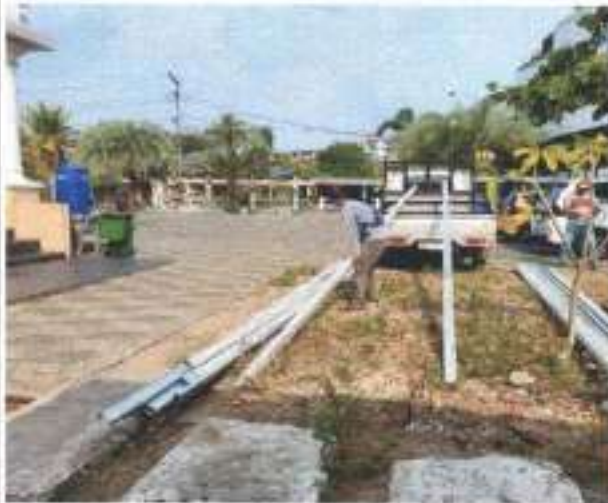
PEKERJAAN PERSIAPAN MOBILISASI MATERIAL DAN PERALATAN
