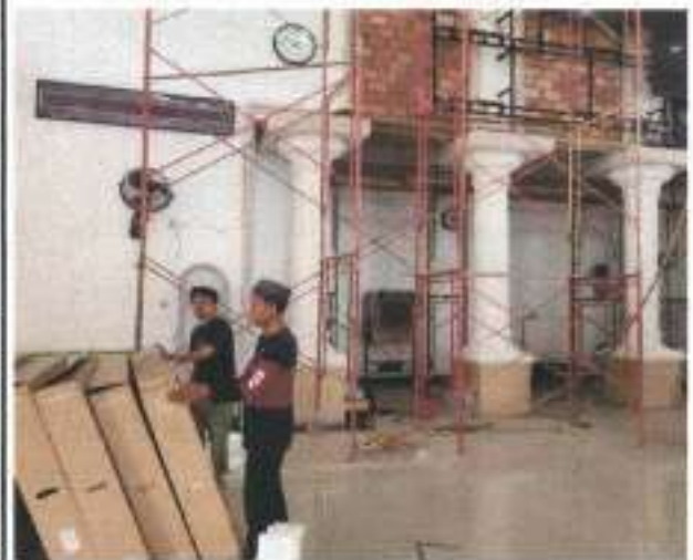
PEKERJAAN ARSITEKTUR PEMASANGAN DINDING MIHRAB
