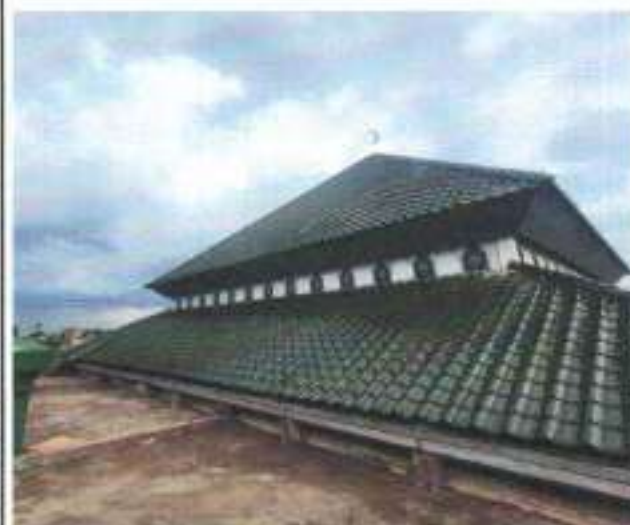
PEKERJAAN ARSITEKTUR PEMBUATAN KACA INLAY
