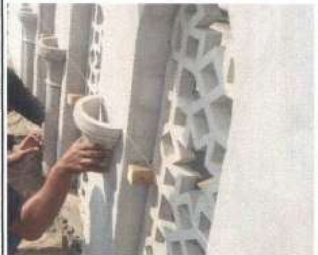
PEKERJAAN ARSITEKTUR PEMASANGAN GRC MOTIF PAGAR PROFIL
