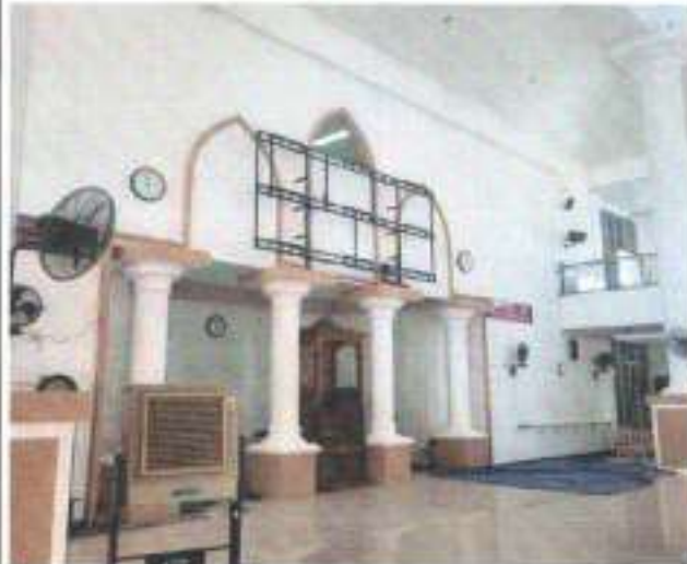
PEKERJAAN PENGECATAN PENGECATAN DINDING GAWANGAN
