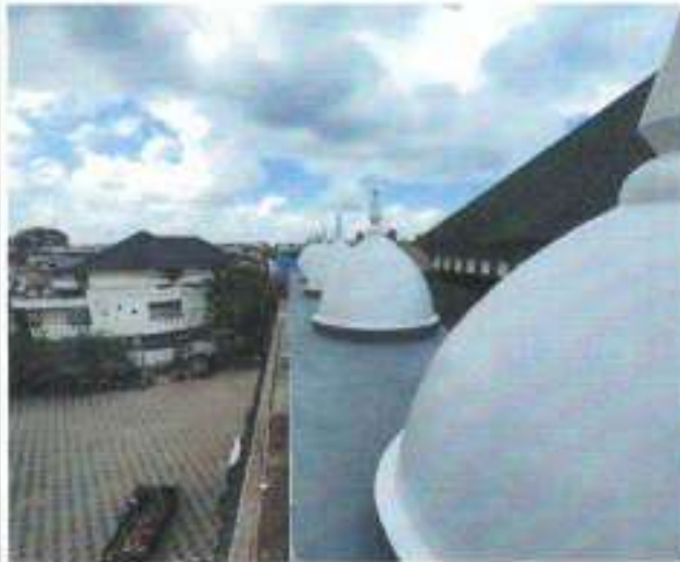
PEKERJAAN PENGECATAN PENGECATAN DINDING GAWANGAN
