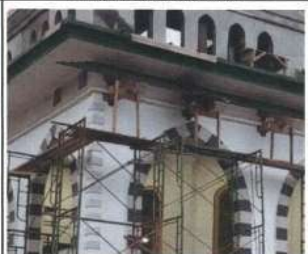
PEKERJAAN STRUKTUR PEMASANGAN RENG BESI HOLLOW
