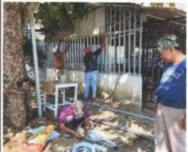
PEKERJAAN PERSIAPAN PEMBUATAN GUDANG MATERIAL
