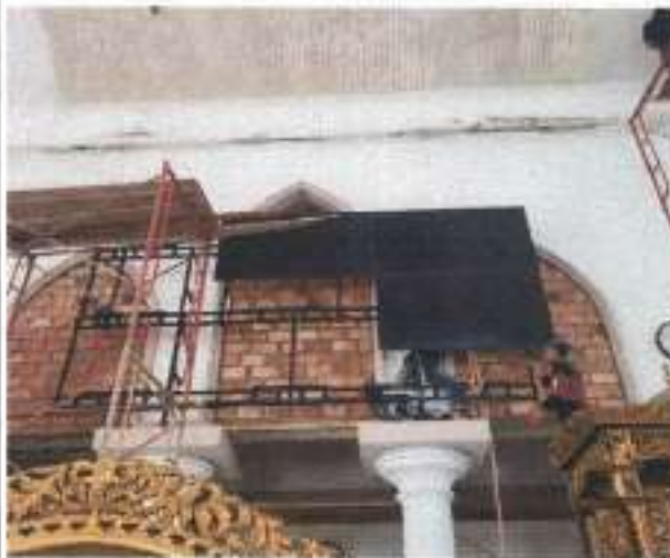
PEKERJAAN ARSITEKTUR PEMASANGAN DINDING MIHRAB
