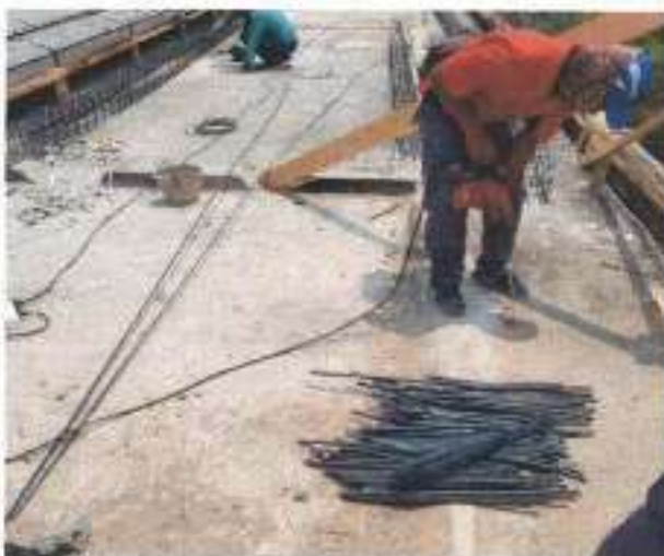
PEKERJAAN STRUKTUR PEMASANGAN STEK REBAR HILT
