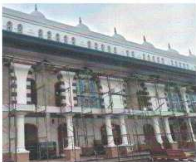
PEKERJAAN PENGECATAN PENGECATAN DINDING GAWANGAN
