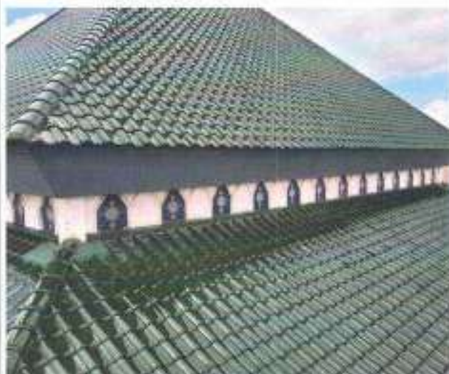
PEKERJAAN ARSITEKTUR PEMBUATAN KACA INLAY
