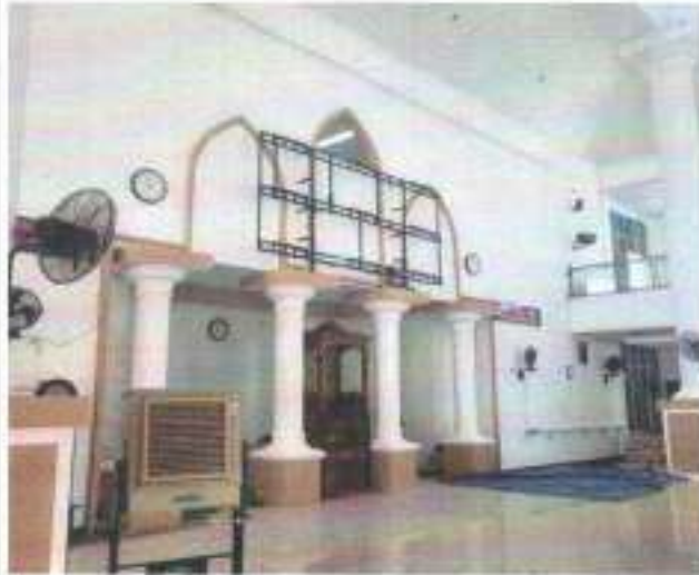
PEKERJAAN PENGECATAN PENGECATAN DINDING GAWANGAN
