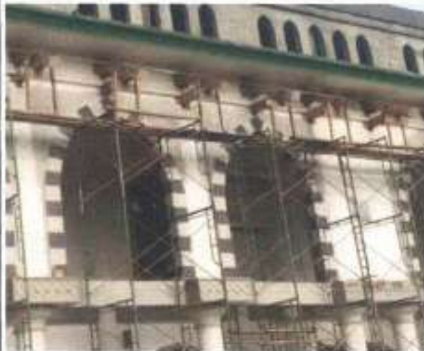
PEKERJAAN STRUKTUR PENGECORAN KLUDA-KLUDA BETON
