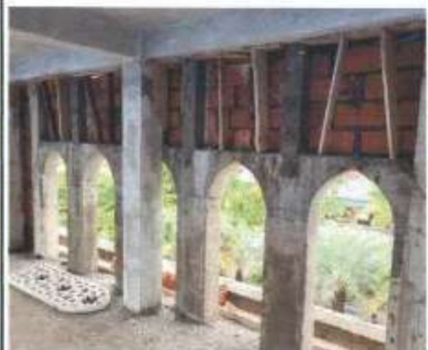
PEKERJAAN STRUKTUR PEMASANGAN BATU BATA PAGAR PROFIL
