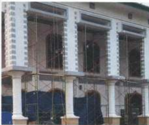
PEKERJAAN PERSIAPAN PEMASANGAN SCAFFOLDING
