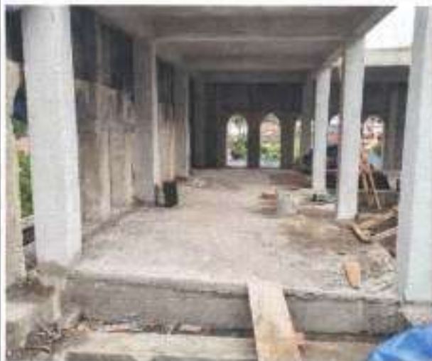
PEKERJAAN STRUKTUR PEMASANGAN STEK REBAR HILTI
