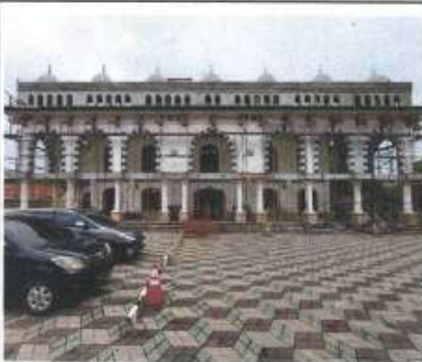
PEKERJAAN PENGECATAN PENDECATAN DINDING GAWANGAN
