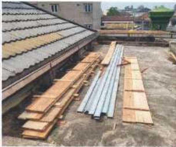
PEKERJAAN STRUKTUR PEMBUATAN BEKISTING KUBAH TELOK
