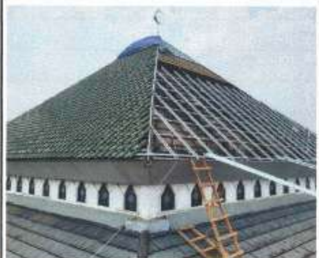
PEKERJAAN STRUKTUR PEMASANGAN GENTENG M-CLASS
