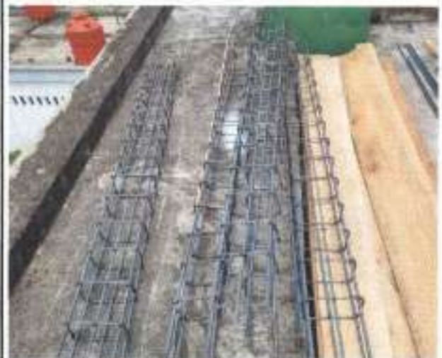
PEKERJAAN STRUKTUR PEMBESIHAN KUBAH TELOK
